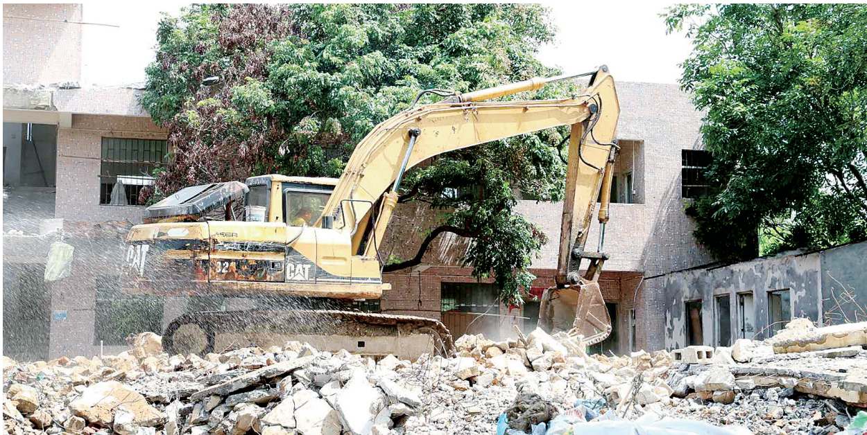
打马坳水库附近的最后一栋房屋被拆除。
