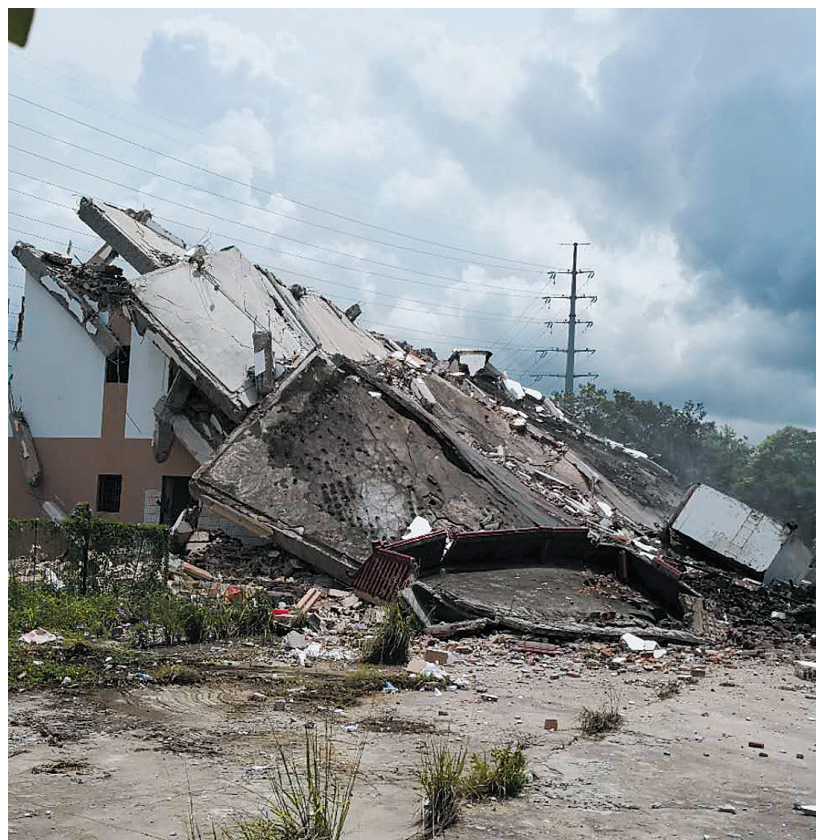
葵涌高速路口一栋六层建筑被拆除。深圳侨报通讯员 张莉 摄
