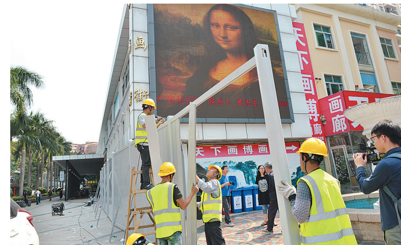
开展大芬水综合整治项目(大芬油画村段)。
