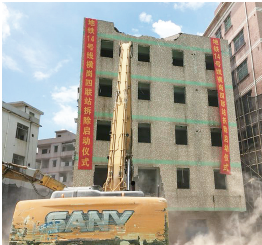
四联站征拆现场。深圳侨报通讯员 刘统中 摄
