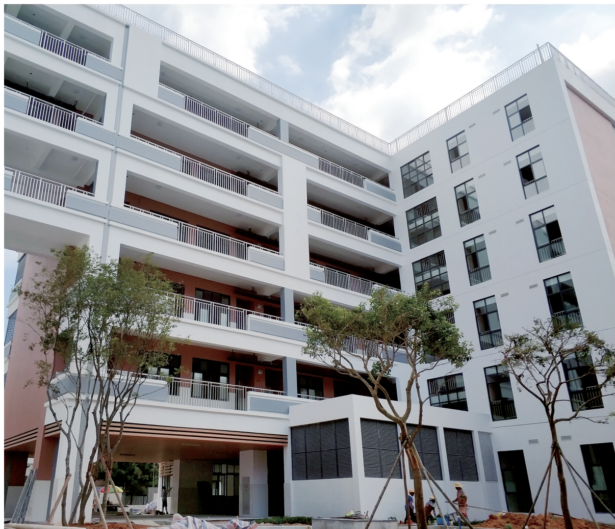
同乐主力学校扩建工程建设现场。
