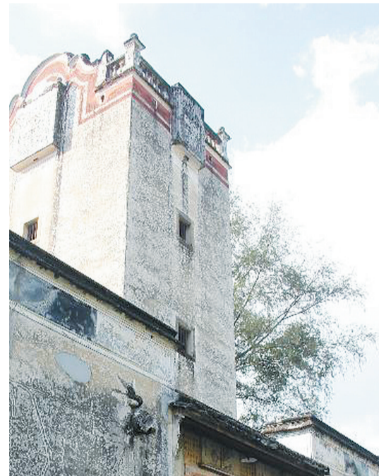
古老的碉楼依然雄伟。
