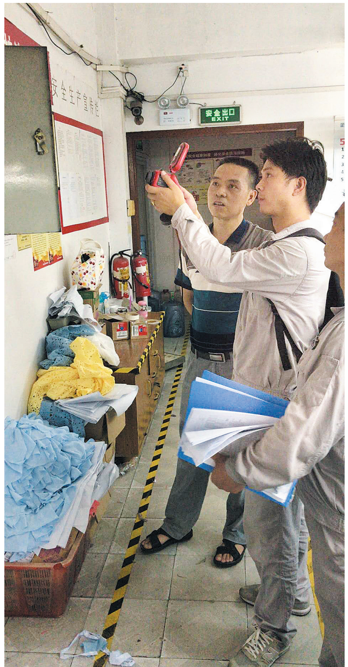
检测电气线路。
