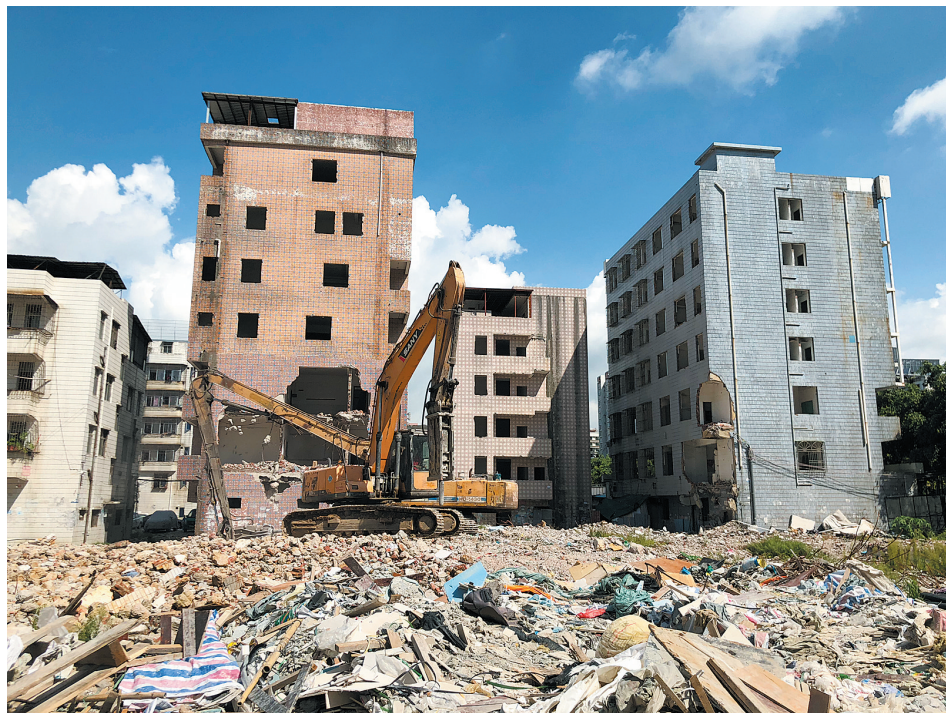
龙岗区第五次集中拆违行动——龙城街道拆除现场。
