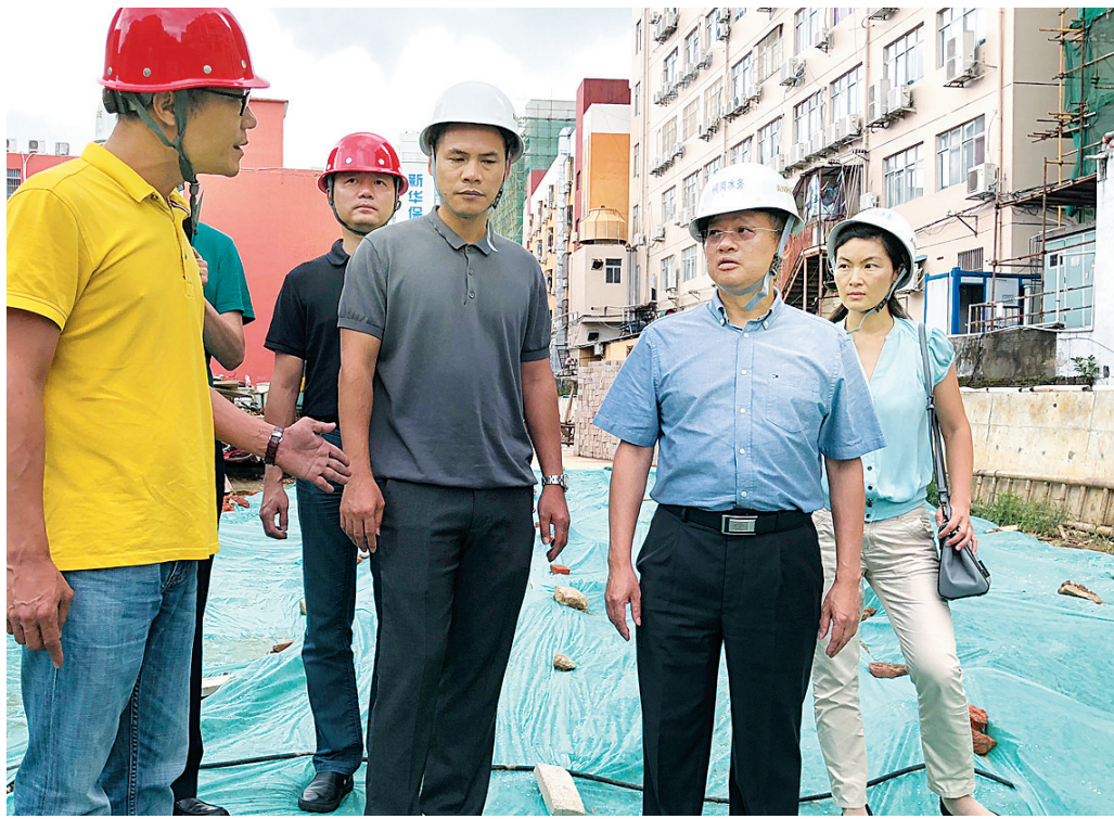
李坚（右二）一行检查四联河综合整治工程进度及防汛情况。深圳侨报记者 陈惠霞 摄
