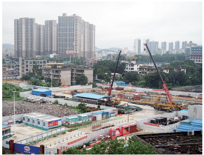
平湖站施工现场。深圳侨报记者 姚兰 摄
