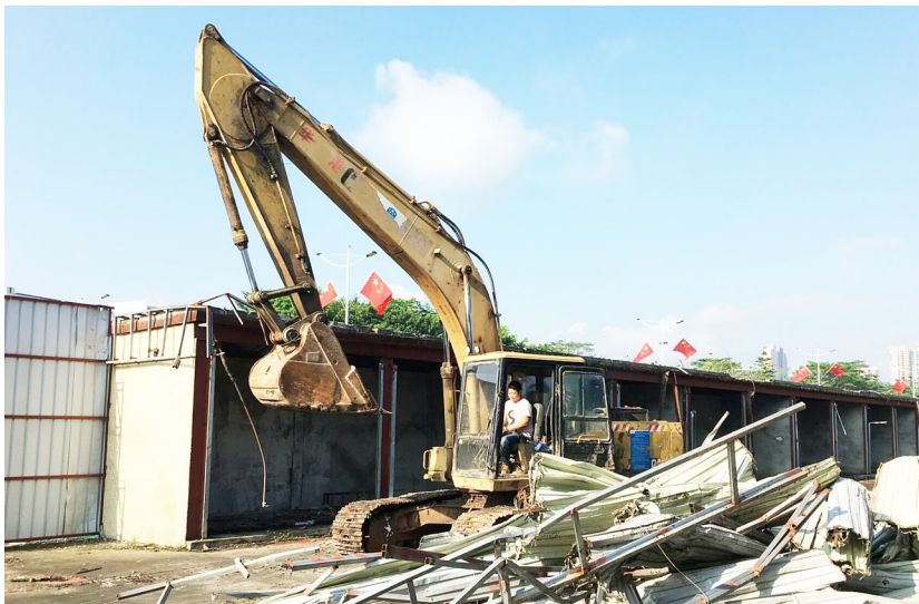
拆除现场。深圳侨报通讯员 熊悦婷 摄
