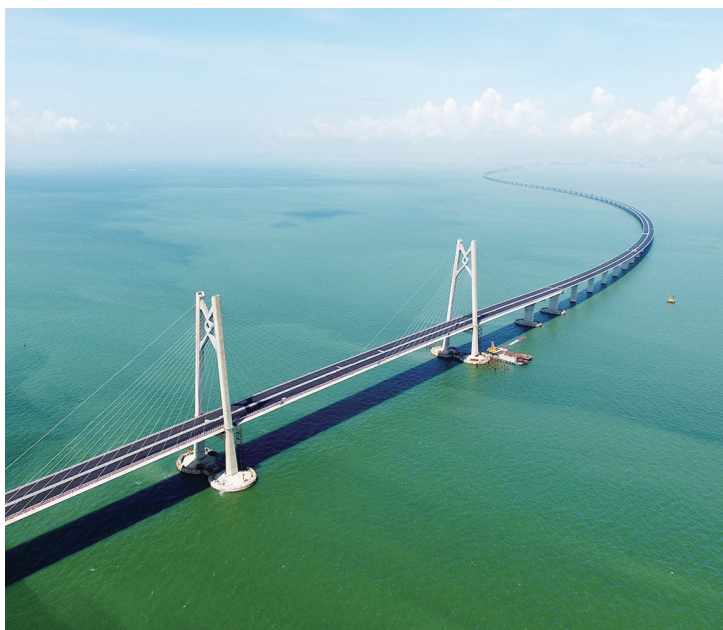
无人机航拍的港珠澳大桥。
