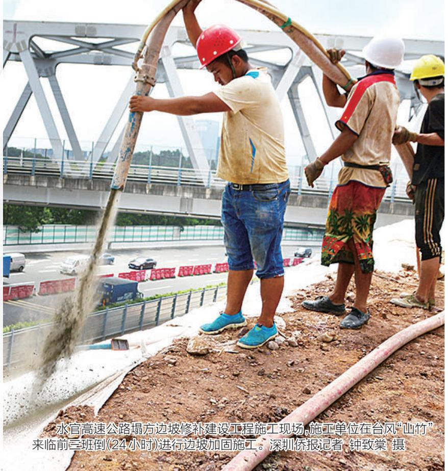
水官高速公路塌方边坡修补建设工程施工现场,施工单位在台风“山竹”来临前三班倒(24小时)进行边坡加固施工。深圳侨报记者 钟致棠 摄
