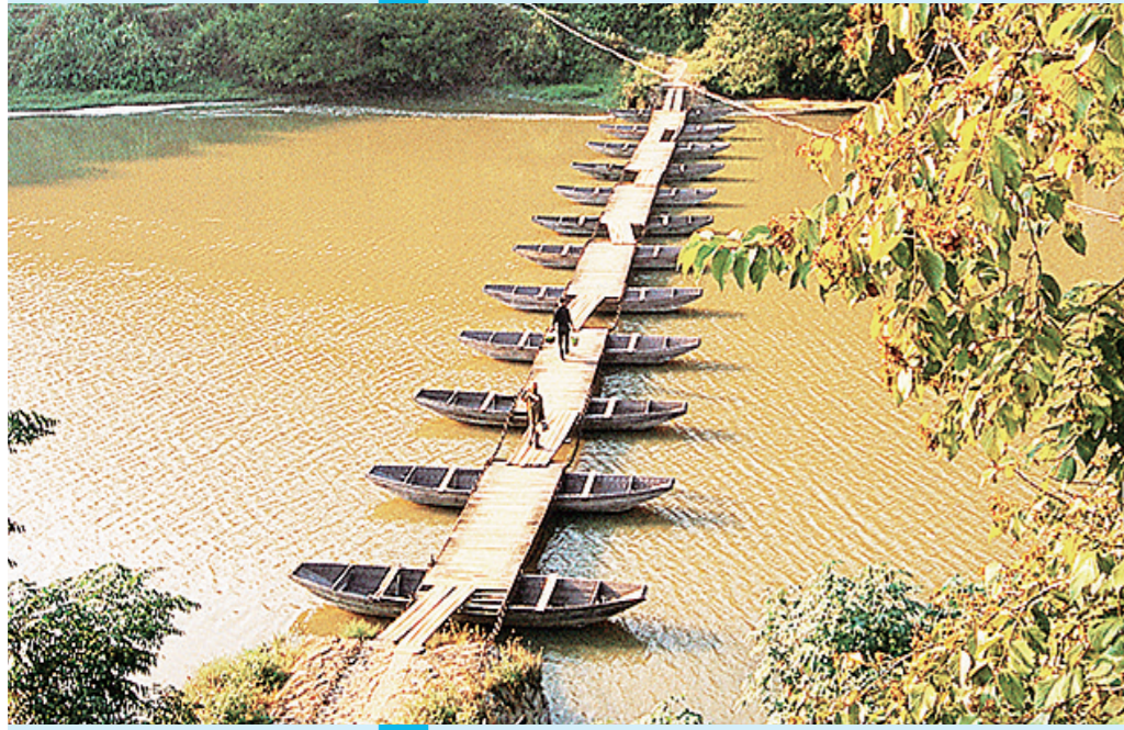
▲名称: 万安浮桥 ▲地点: 福建浦城县 ▲特色: 十二只木船一字排开, 两条铁链把船串在一起, 两岸锚定, 船桥马时, 桥头眺望南山岭, 诗句道出了人们过浮桥后的心境。『造船为梁, 比船于水』可见, 万安乡桥头村浮桥已有较长历史。惜别浮上铺木板, 人走在桥上如履平地。万安乡的老者说, 三年前桥头村就
