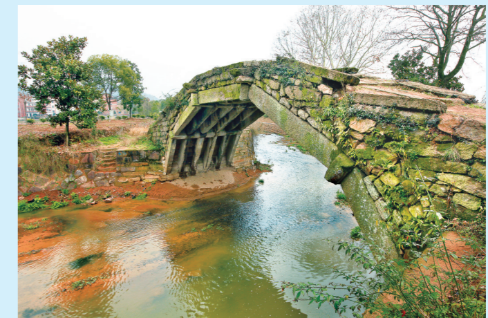
▲名称: 古石桥 ▲地点: 浙江义乌市 ▲特色: 建于宋嘉定六年, 为单孔五边形石拱桥, 采用单拱纵联分节并列砌筑法建造, 既具有与圆
