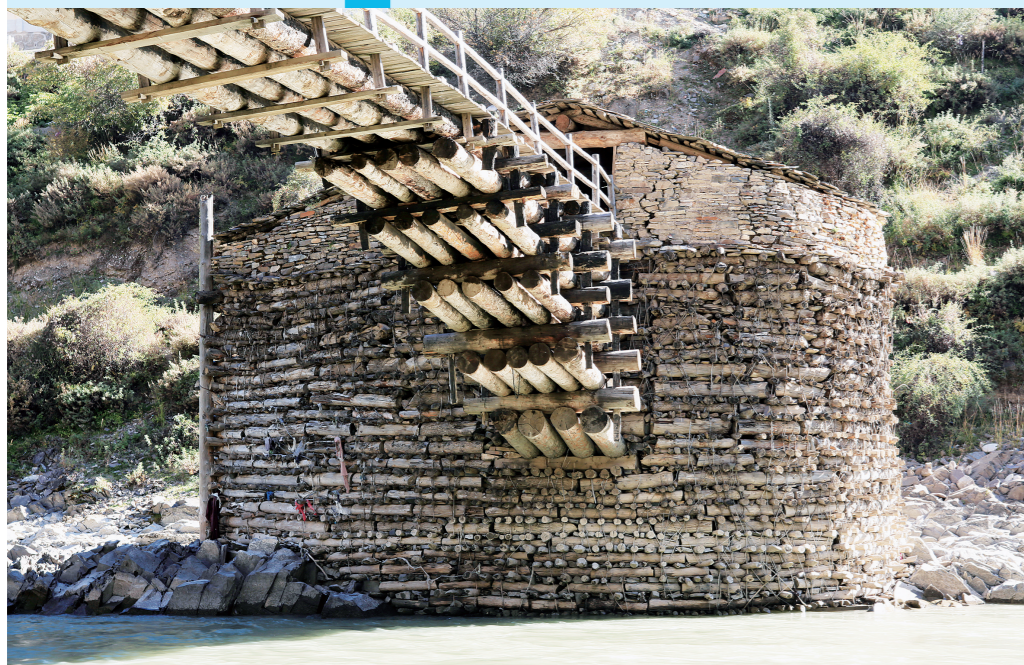
▲名称: 波日桥 ▲地点: 四川新龙县 ▲特色: 为单孔伸臂木廊桥, 建于清代, 长约10米, 宽1米, 孔径跨度2米。桥下雅砻江水声咆哮, 被称为『康巴第一桥』。用圆形木、卵石、片石相同叠砌而成。位于海拔2000多米的高原藏区, 米, 为藏族设计师唐通吉布设计。桥墩造型如两个坚固的碉堡, 全部
