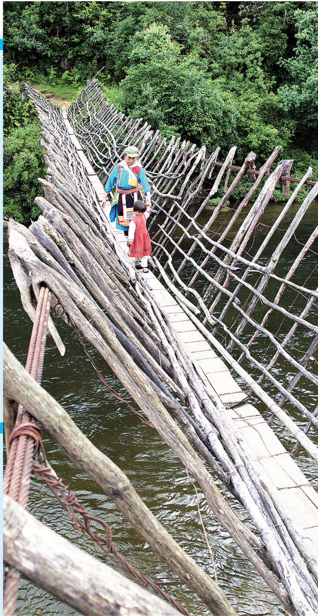
▲名称: 三岔河藤桥 ▲地点: 云南腾冲市 ▲特色: 跨越蜿蜒流淌的秧榔江, 长约20多米, 上宽下度差不多, 徐霞客曾记, 仅容一人行走, 『不可渡马也』。窄, 呈『△』字形, 桥面由数块木板相拼, 宽度跟一只脚的长
