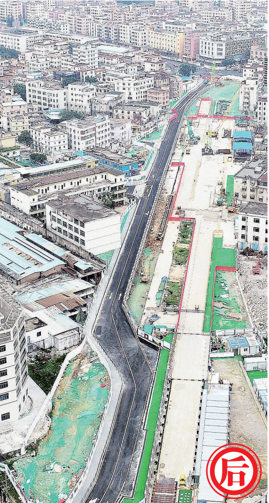
红棉路二期疏解路顺利完工,标志着红棉路全线通车。
