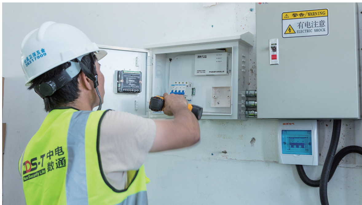
施工人员正在安装远程用电监测系统,对电气设备进行实时监控。
