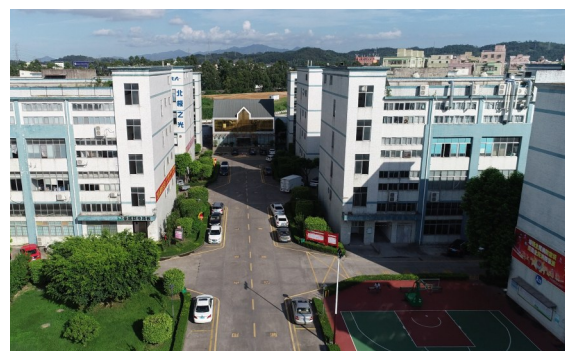
华夏园工业区将打造为坪地街道电气火灾整治示范园区。
