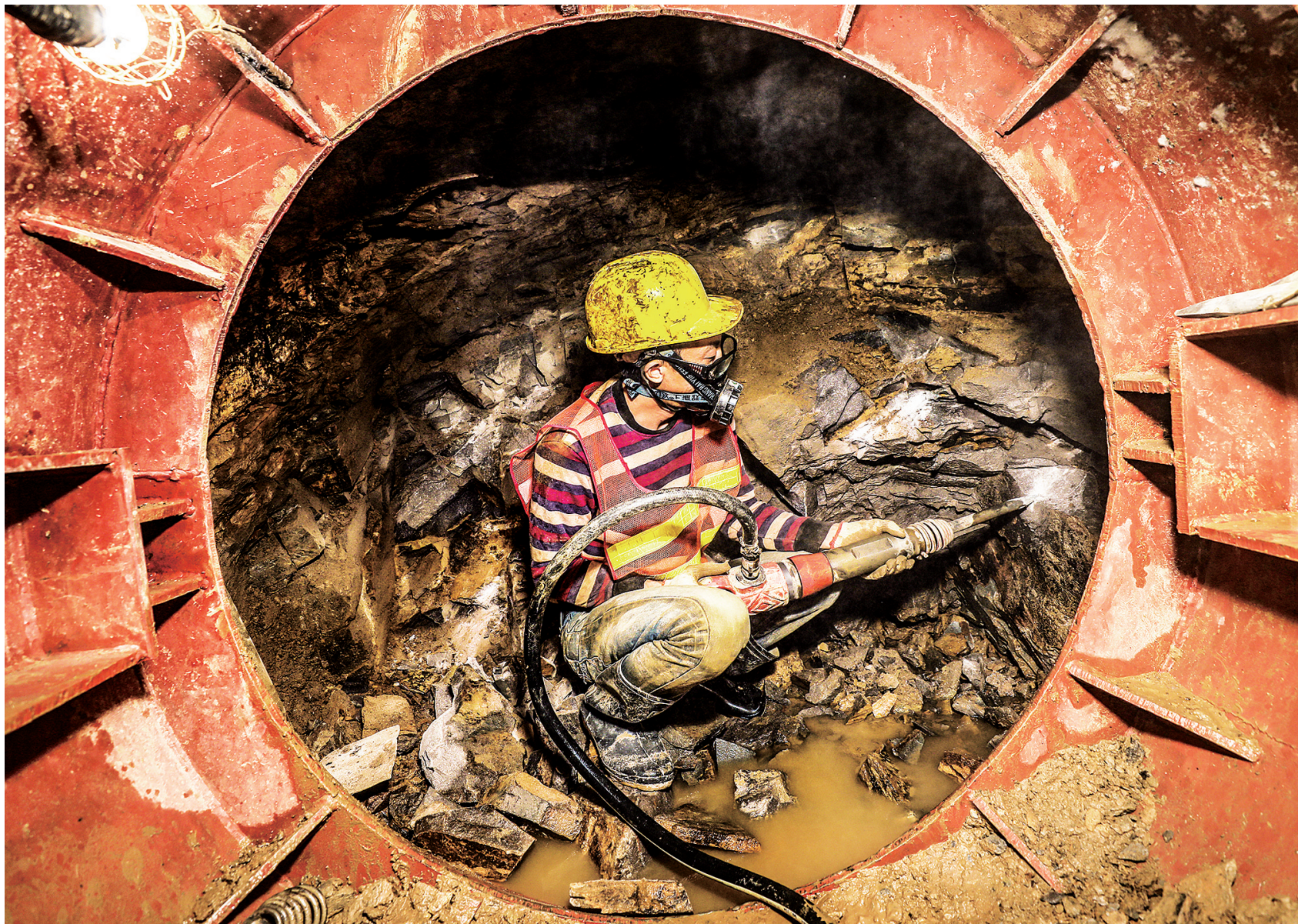
夜以继日提效率,创意频出解难题。自今年7月进入治水提质“战时状态”以来,龙岗区黑臭水体整治全面提速。如今,24条黑臭水体治理进入冲刺阶段,各项整治工程频频“逆袭”,不断取得喜人战果。图为西湖水黑臭水体综合治理工程中,工作人员在顶管工作井加紧施工。(详见A03、A04版) 深圳侨报通讯员 许能裕 摄
