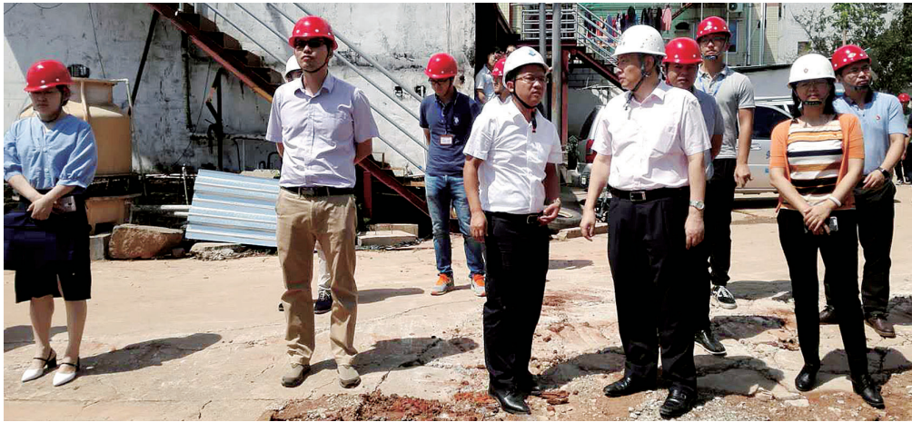
作为浪背水驻挂河长的龙岗区委常委、宣传部长胡庚祥(前右二)多次深入施工现场调研指导工作。
