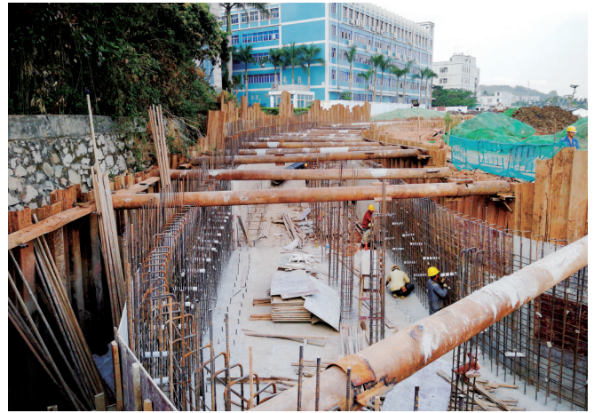
浪背水黑臭水体截污工程施工现场。
