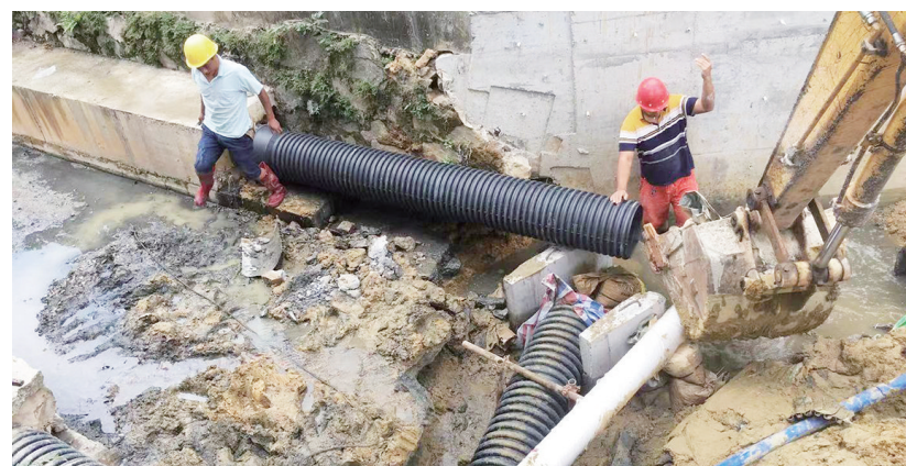
莘塘排水渠施工现场。深圳侨报通讯员 张磊 摄
