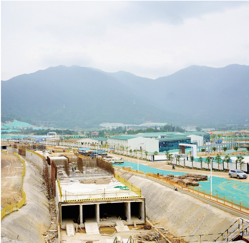
环坝路综合管廊施工现场。深圳侨报通讯员 吴依妮 摄
