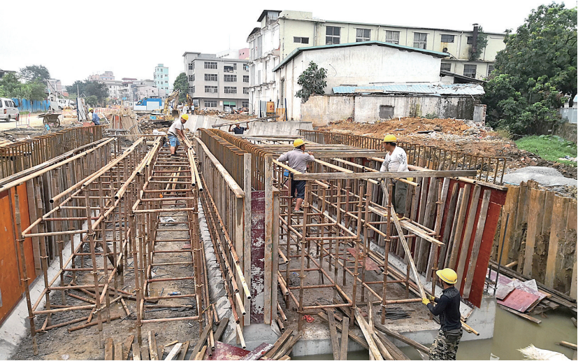
项目部加班加点加紧君子布河支流一截污主体施工。
