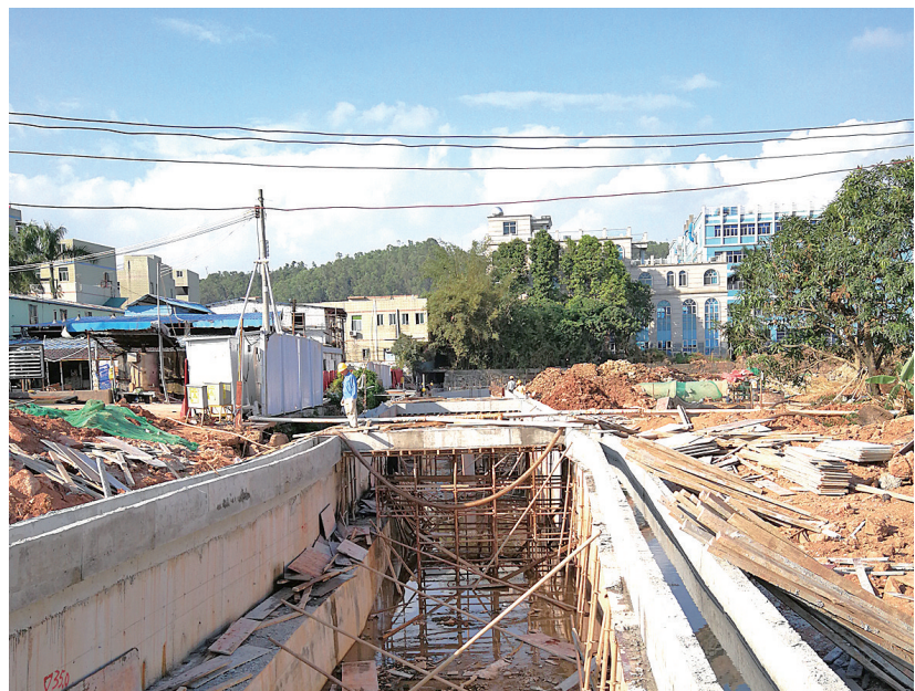
浪背水黑臭水体治理工程现场。
