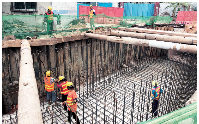
三棵松水黑臭水体治理工程现场。
