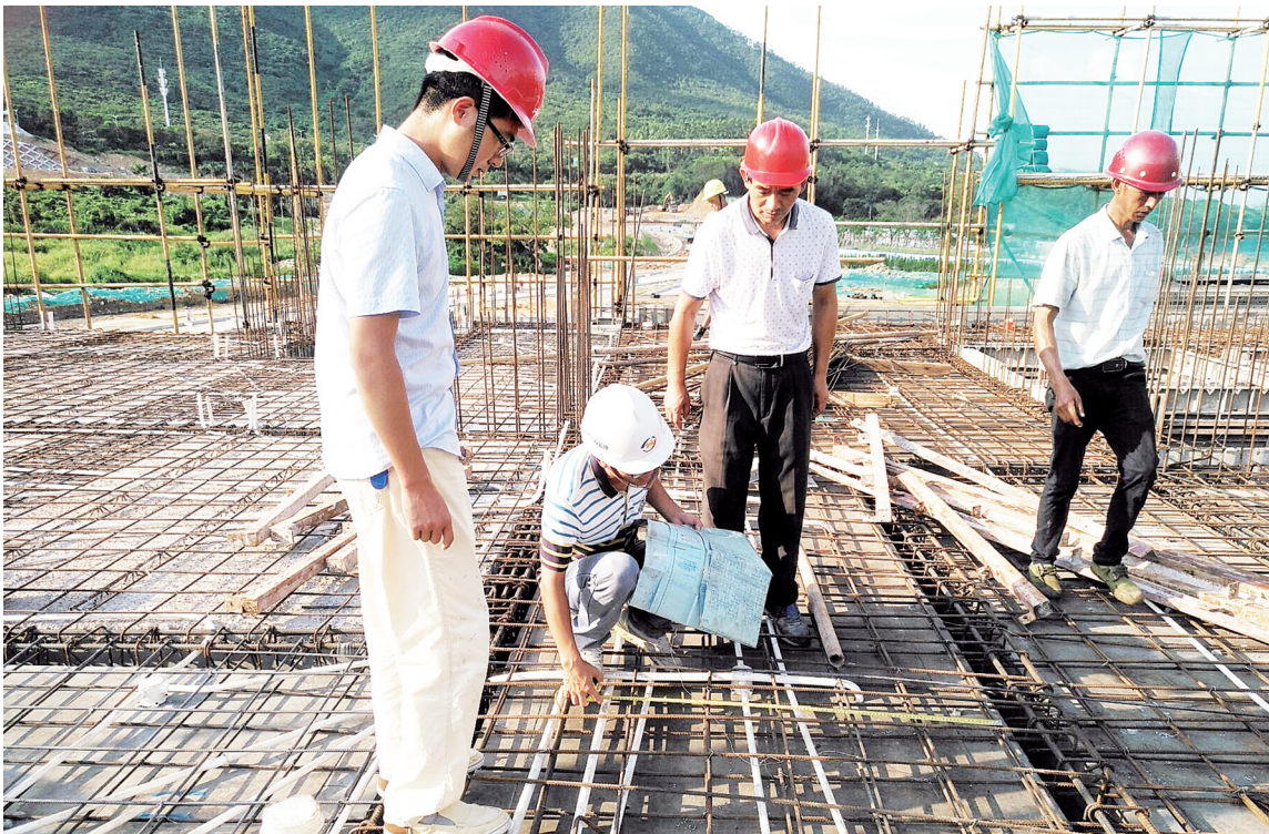
新区建筑工务局行走工地检查安全。
