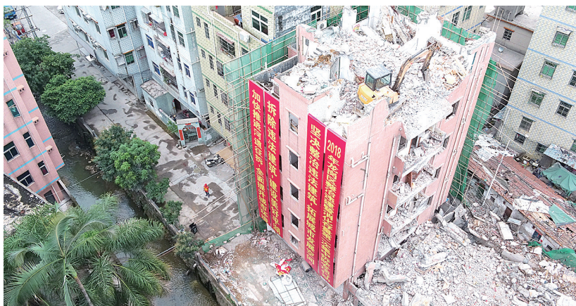
2018年整治违建暨消化存量第2次集中拆除专项行动平湖拆除现场。
