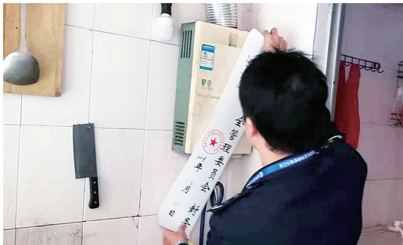
查封直排式热水器。深圳侨报记者 张臻斐 摄
