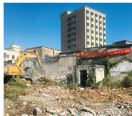
碧新路最后一栋房屋征拆现场。
