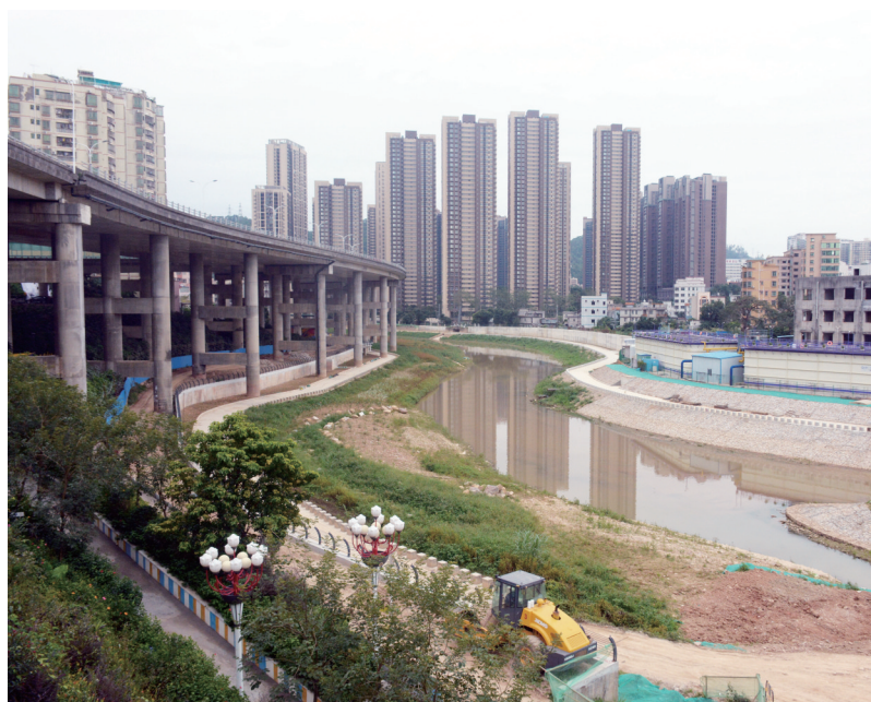
正在紧张施工的沙湾河沿岸景观工程。
