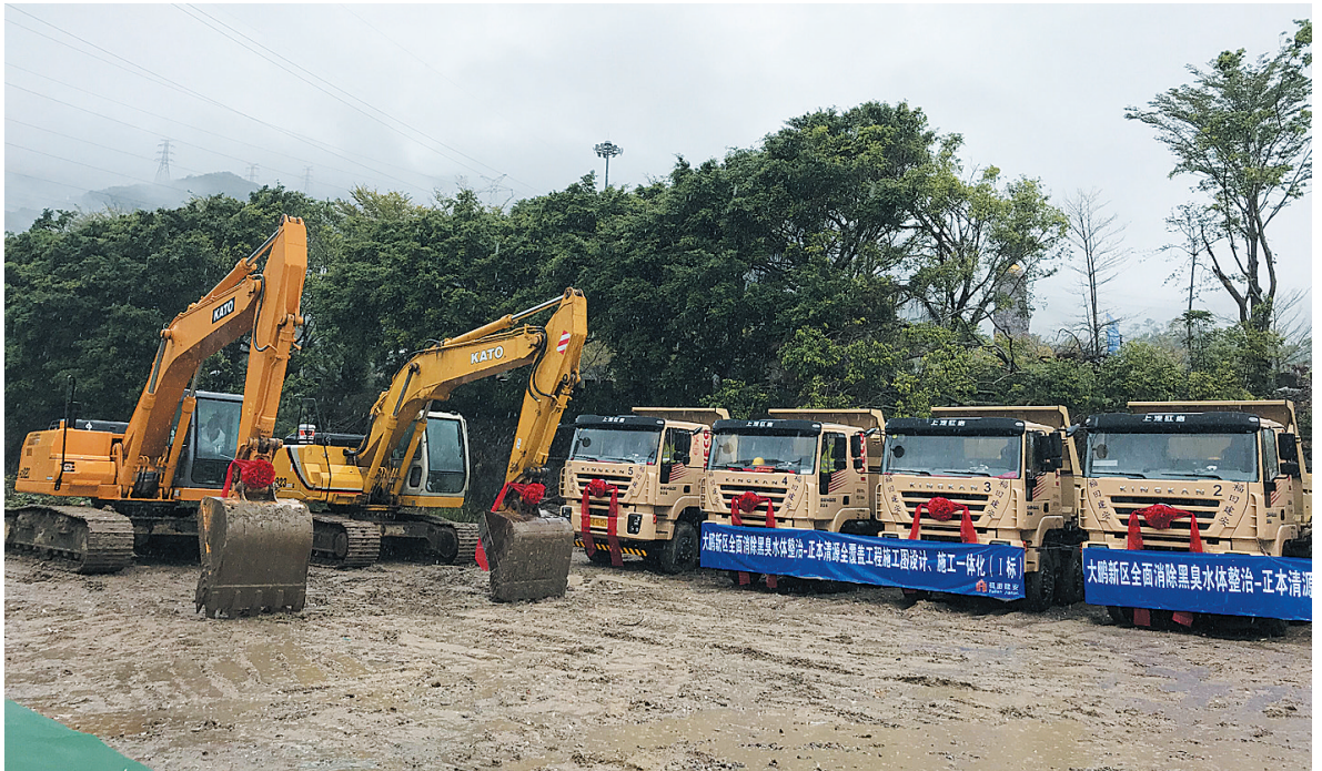
集中开工现场。侨报融媒记者 李苑 摄
