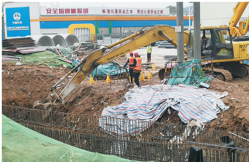
施工现场。侨报融媒记者 尹萌 摄
