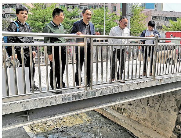
街道党工委委员、武装部长严学雄(中)带队巡查河道治理现场。
