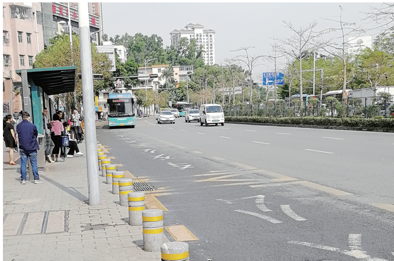
上水径公交站第一个停车位没有站台。
