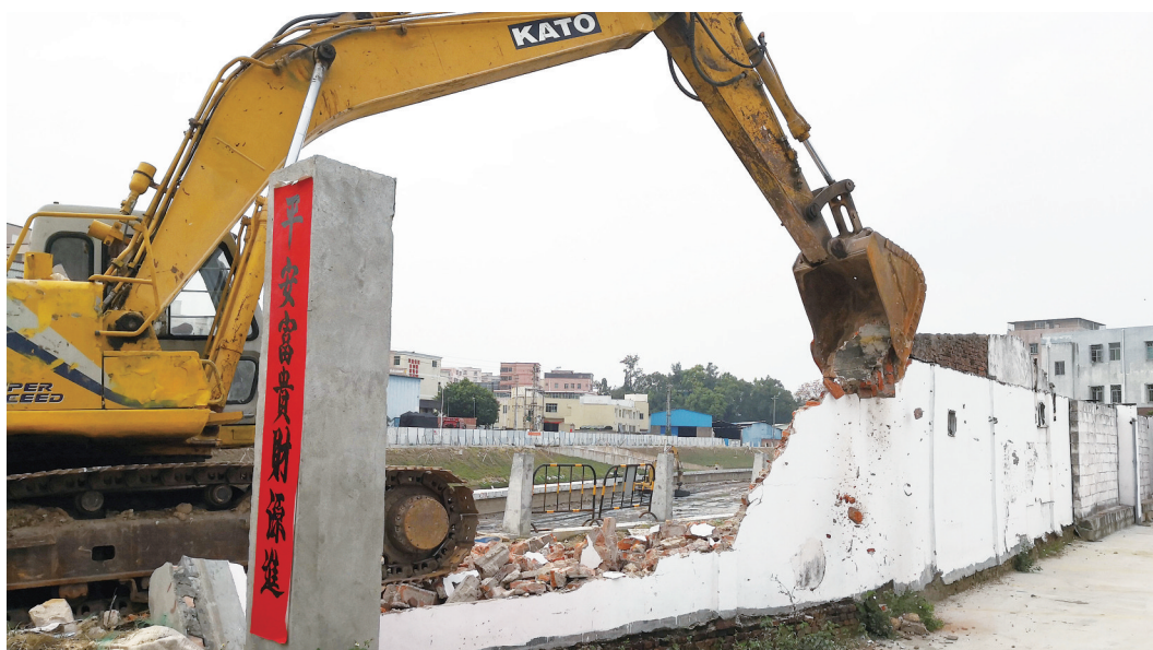
拆除现场。侨报融媒记者 张臻斐 摄
