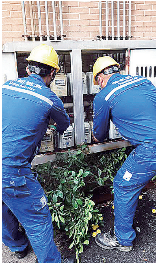
维修人员进行排查。
