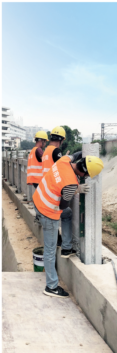
施工单位工作人员安装塘径水巡河河道护栏。
