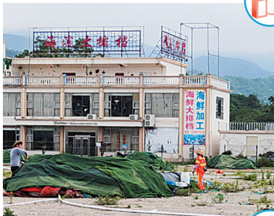
工作人员对原游乐场废弃材料设施等进行清理。
