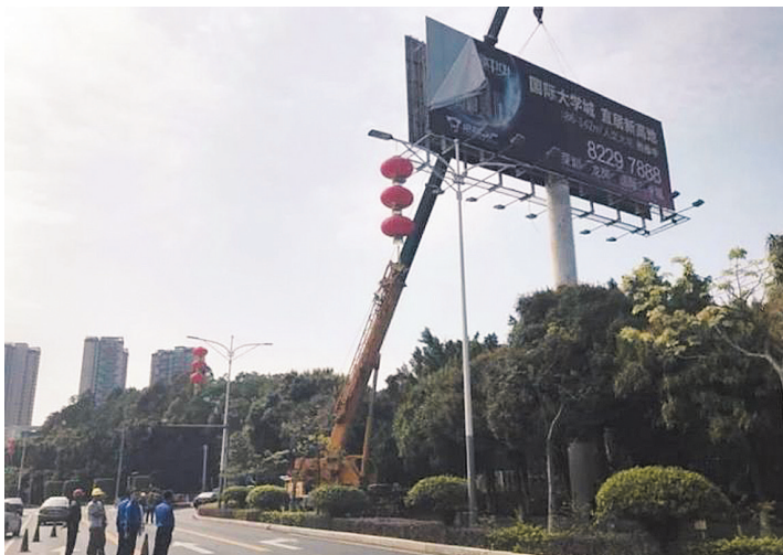
立柱广告拆除现场。侨报融媒通讯员 袁峰 摄
