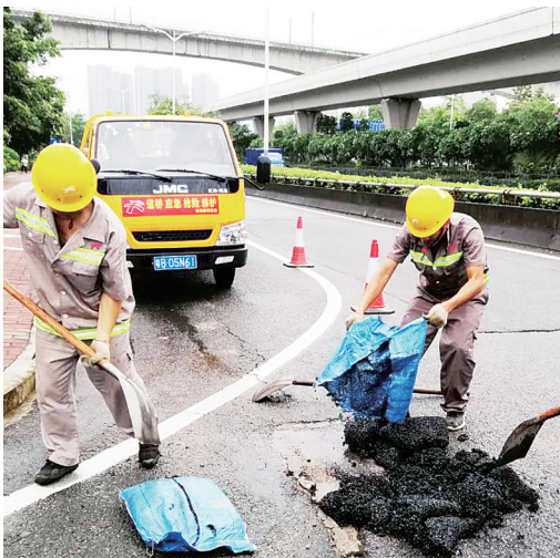
工作人员修复破损路面。 市交通运输局龙岗管理局供图
