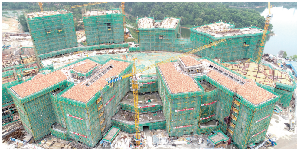
深圳外国语学校(龙岗)国际部永久校区新建工程主体结构封顶。
