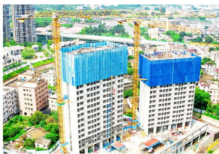
项目主体结构封顶。深圳侨报记者 张丽 摄
