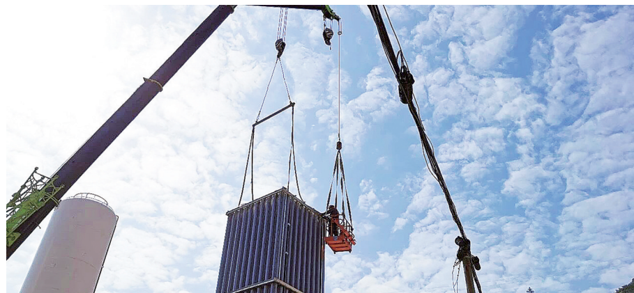
坝光LNG气化站项目设备储罐吊装作业现场。坝光开发署供图
