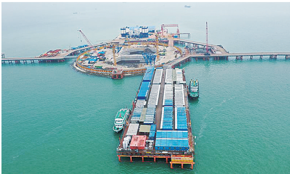
伶仃洋大桥施工区与海上生活区。新华社发
