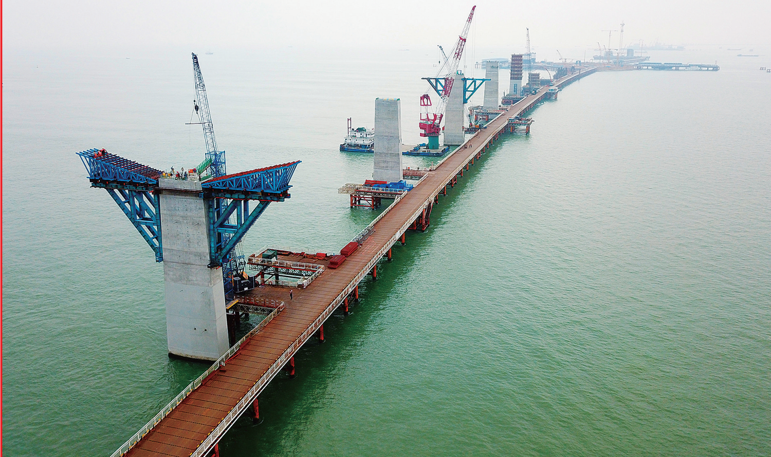
粤港澳大湾区正在如火如荼建设中,区内基础设施日益完善。图为深中通道伶仃洋大桥施工段建设稳步推进。新华社发
