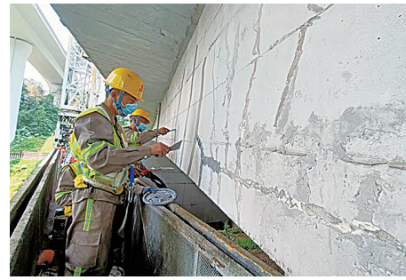
工人及时整治桥梁排水设施。龙岗融媒记者 杜和平 摄
