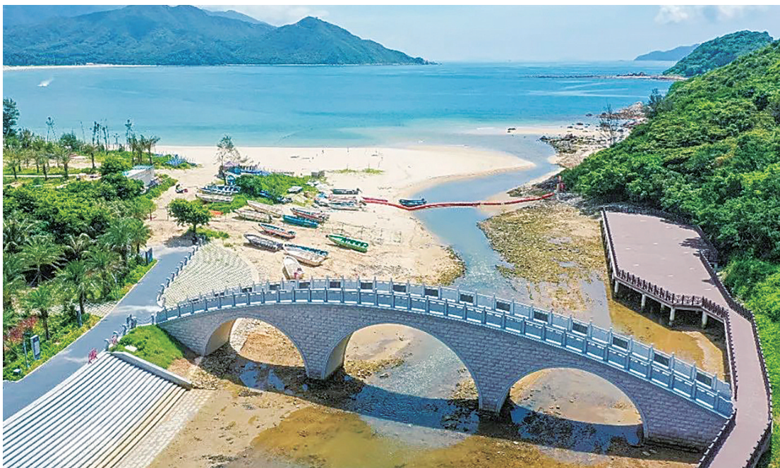
西涌河防洪达标整治工程。新区建筑工务署供图
