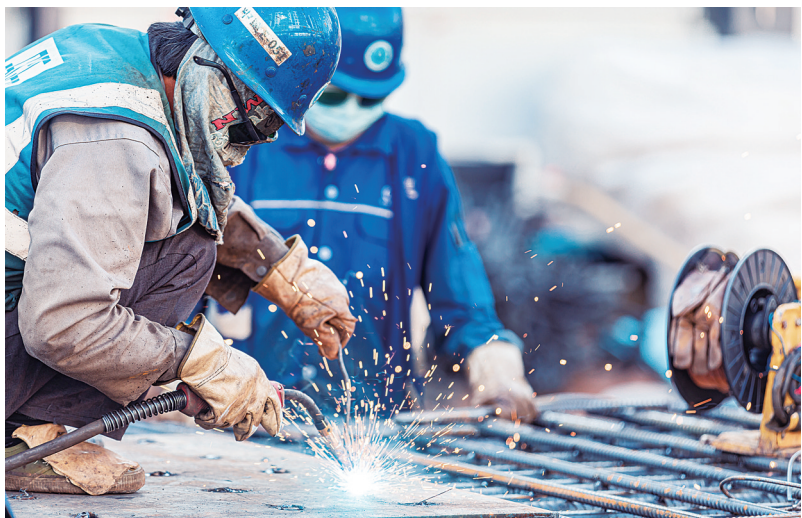
在工地“全副武装”的钢筋切割工人。
