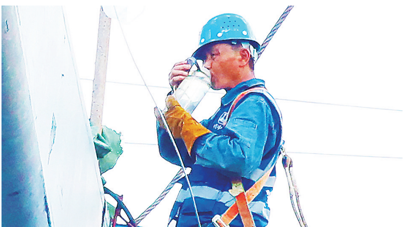
顶着骄阳作业的电路检修工人。
