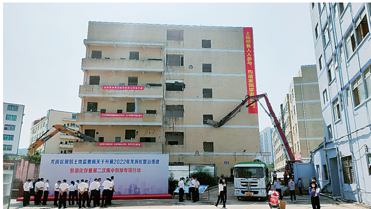
违建拆除现场。
