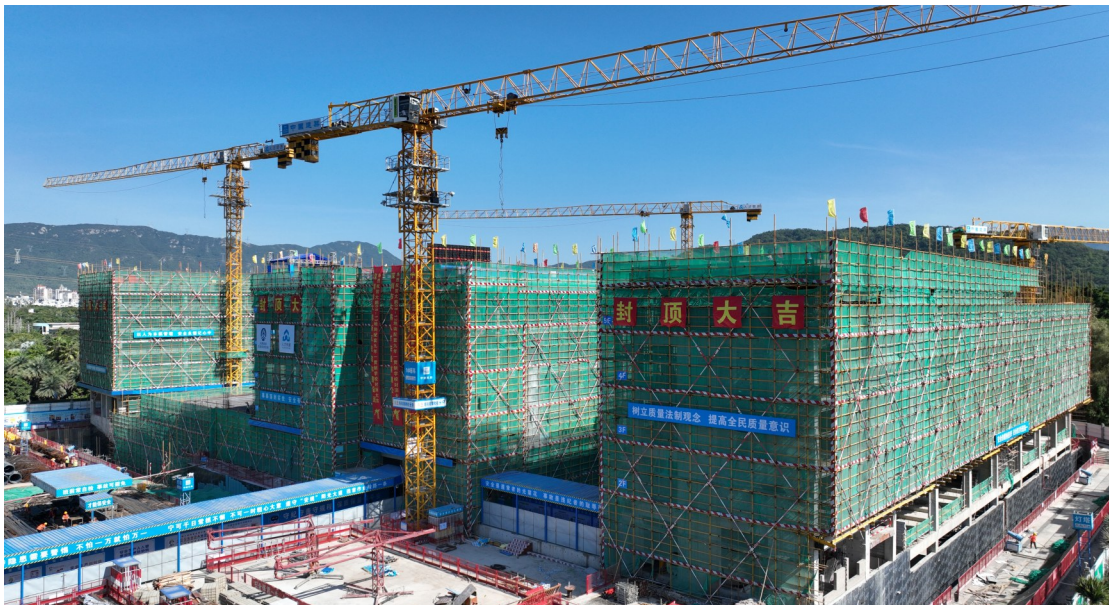
深圳中学大鹏学校全面封顶。深圳侨报通讯员 林宏松 摄
