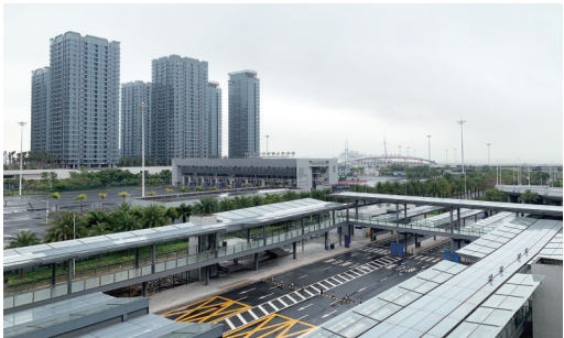
港珠澳大桥珠海公路口岸。
