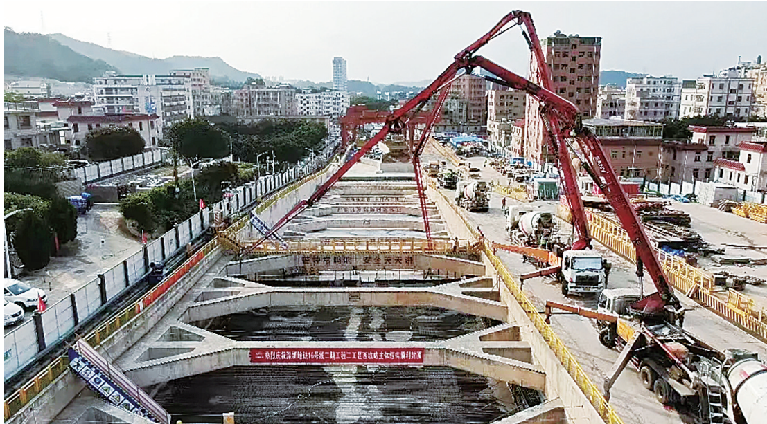
地铁16号线二期西坑站施工现场。龙岗融媒通讯员 廖东 摄
