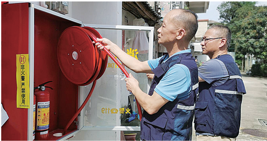
社区工作人员检查消防卷盘。深圳侨报通讯员 李若石 摄
